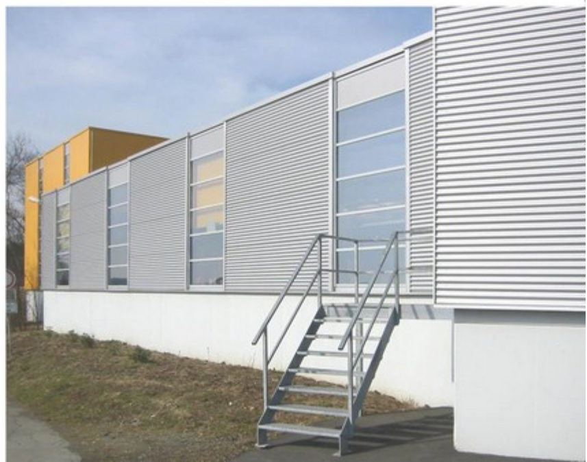
An- und Umbau einer Produktions- und Lagerhalle Fa. SIPLAST, Kreuztal
